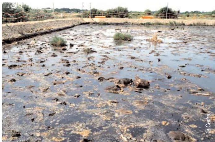
Alvéole du stockage lourd des MPP de l'Erika : polluant pâteux en attente d'un transfert vers l'unité de traitement. Donges, Loire Atlantique (44).
