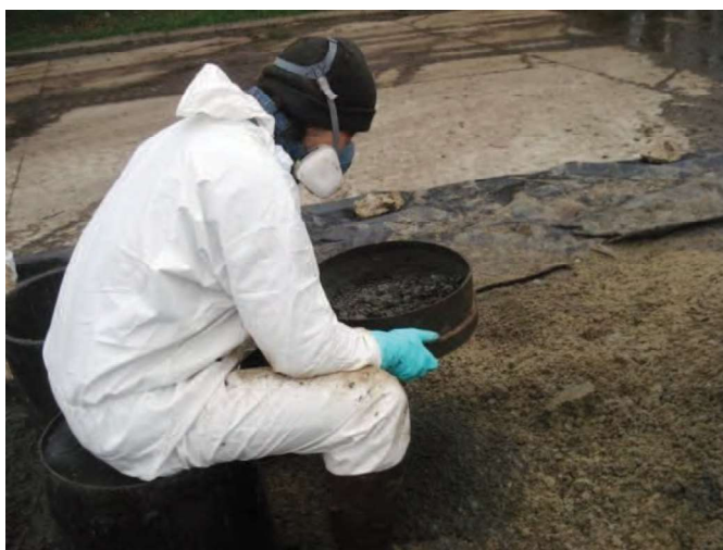
Criblage manuel du sable (Source : Le Floch Depollution)
